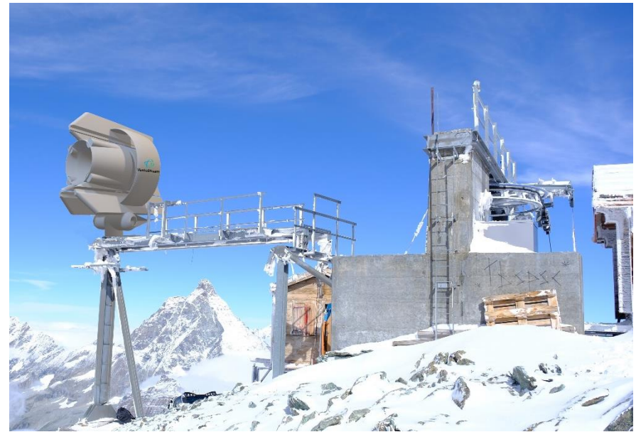
Projekt erste Anlage auf Kleinmatterhorn Durchmesser 3m, 100 kW, Gewicht 1.5 t
